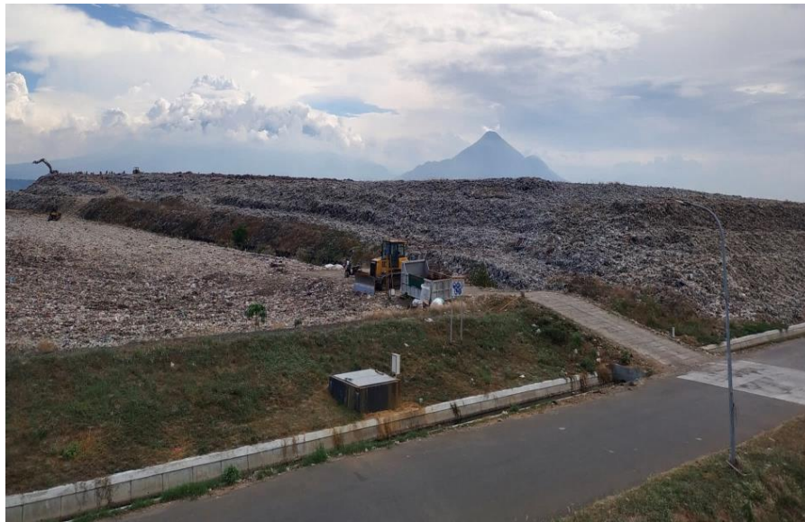
Gambar 5. 24 Dokumentasi Area Landfill Lama (kanan) dan Baru (kiri)
